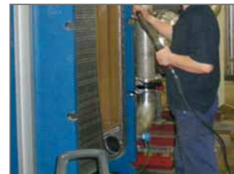
Pulizia in loco del pacco piastre
