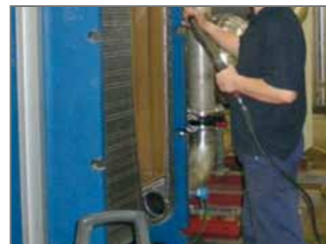
Pulizia in loco del pacco piastre
